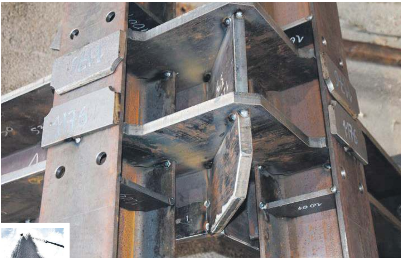
Slika 7. Zapadna (toranjska) skela – od modela do izvedbe
