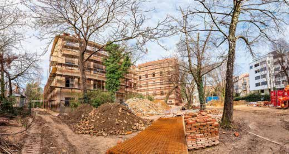
Obnova je u punom tijeku
