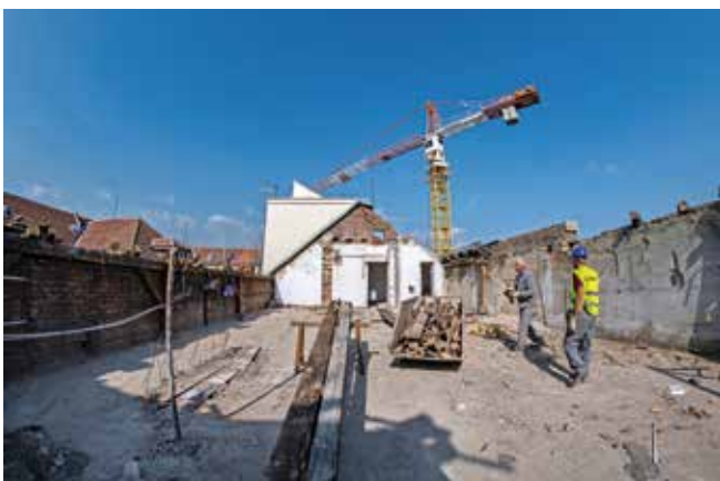
Zgrada je obnovljena i ojačana od podruma do krovništa
