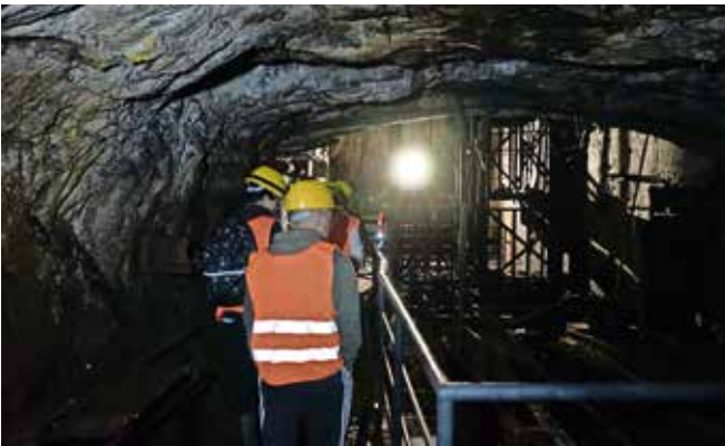
Prolaz prema dizalu za vagonete u podzemnoj prostoriji
