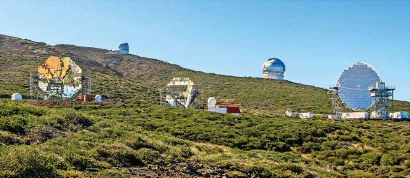
Lijevo dva teleskopa MAGIC, čiji je promjer zrcala 17 m, desno teleskop LST-1 promjer zrcala 23 m, prvi izgrađeni teleskop budućeg sjevernog CTA opservatorija
