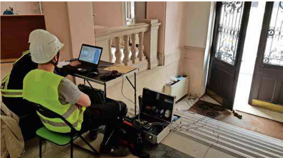
SLIKA 3: Preliminarni monitoring na zgradi HŽ Infrastrukture
