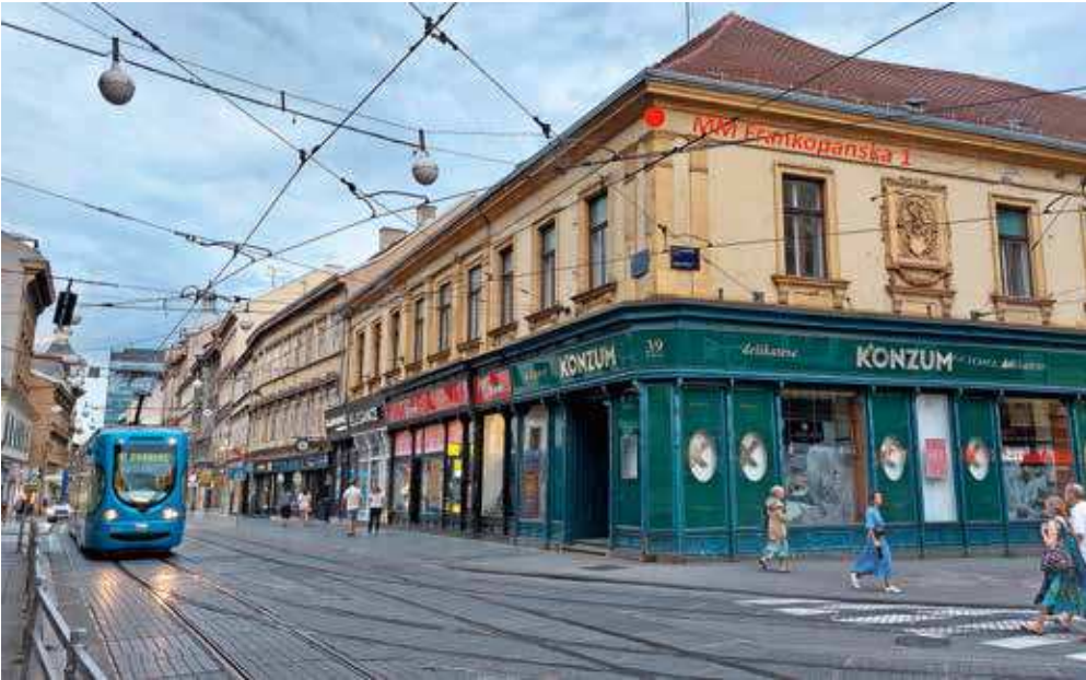
SLIKA 5a: Mjerna lokacija na 2. etaži zgrade (Frankopanska 1)
