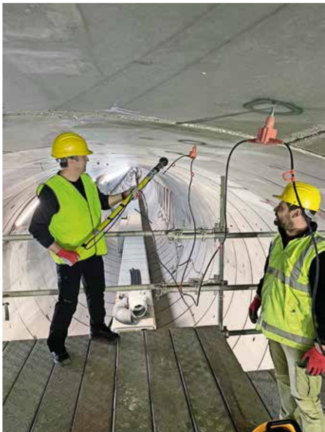
Generiranje umjetnog udara na betonskoj oblozi
